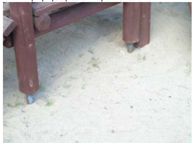
6. Rdza na elementach metalowych zestawu zabawowego na placu zabaw ul. Łokietka 49..
