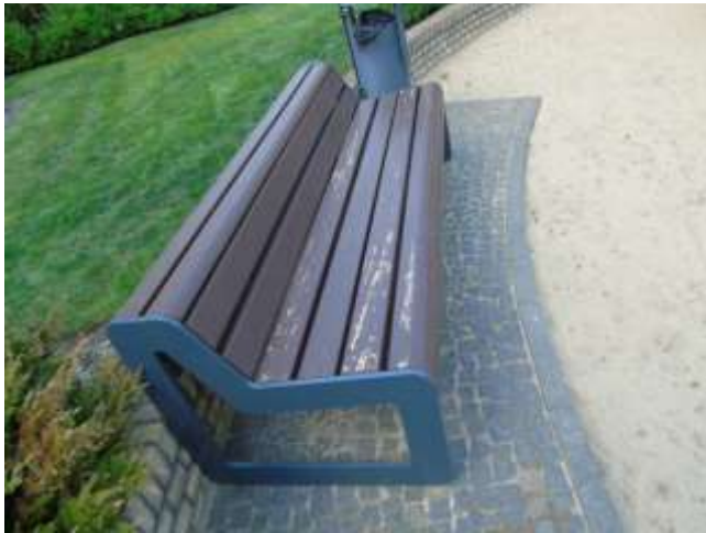
1. Przetarcia , odbarwienia , brak impregnacji na elementach drewnianych ławki placu zabaw ul. Łokietka 49
